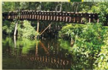
Steel bridge. Mark Schweder
